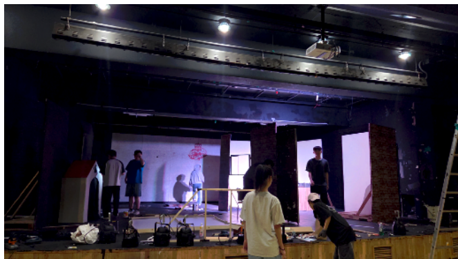
무대 설치 작업
