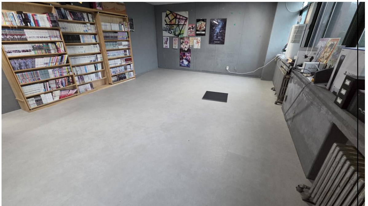
동아리방의 노후된 바닥 보수 공사 전, 후 비교 사진
